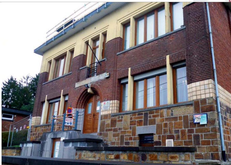
Bâtiment de l'AIGS de Soumagne actuellement en rénovation
